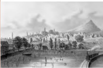
1856 : découverte de pieux dans la baie de Grésine par M Buvelot (ingénieur ferroviaire) (Source : DDE 73)
