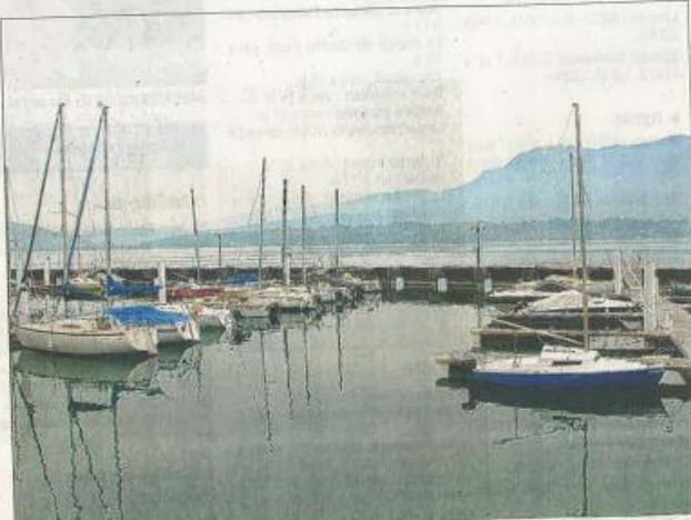
La tempête d'octobre dernier avait provoqué d'importants dégâts dans le port de Charpignat au Bourget-du-Lac. Un budget de 150 000 euros a été affecté par la Calb pour conforter la digue du port. Photo archives La Calb.
