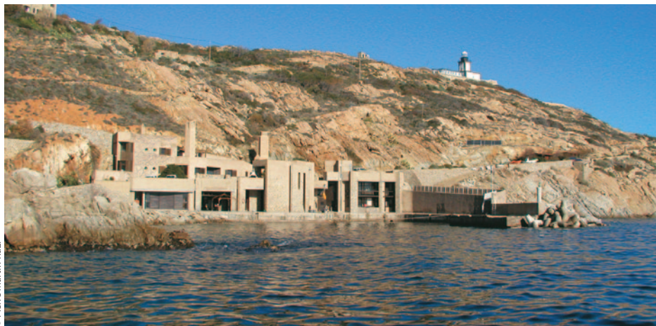
Une architecture parfaitement intégrée au paysage de la pointe de la Revellata.
